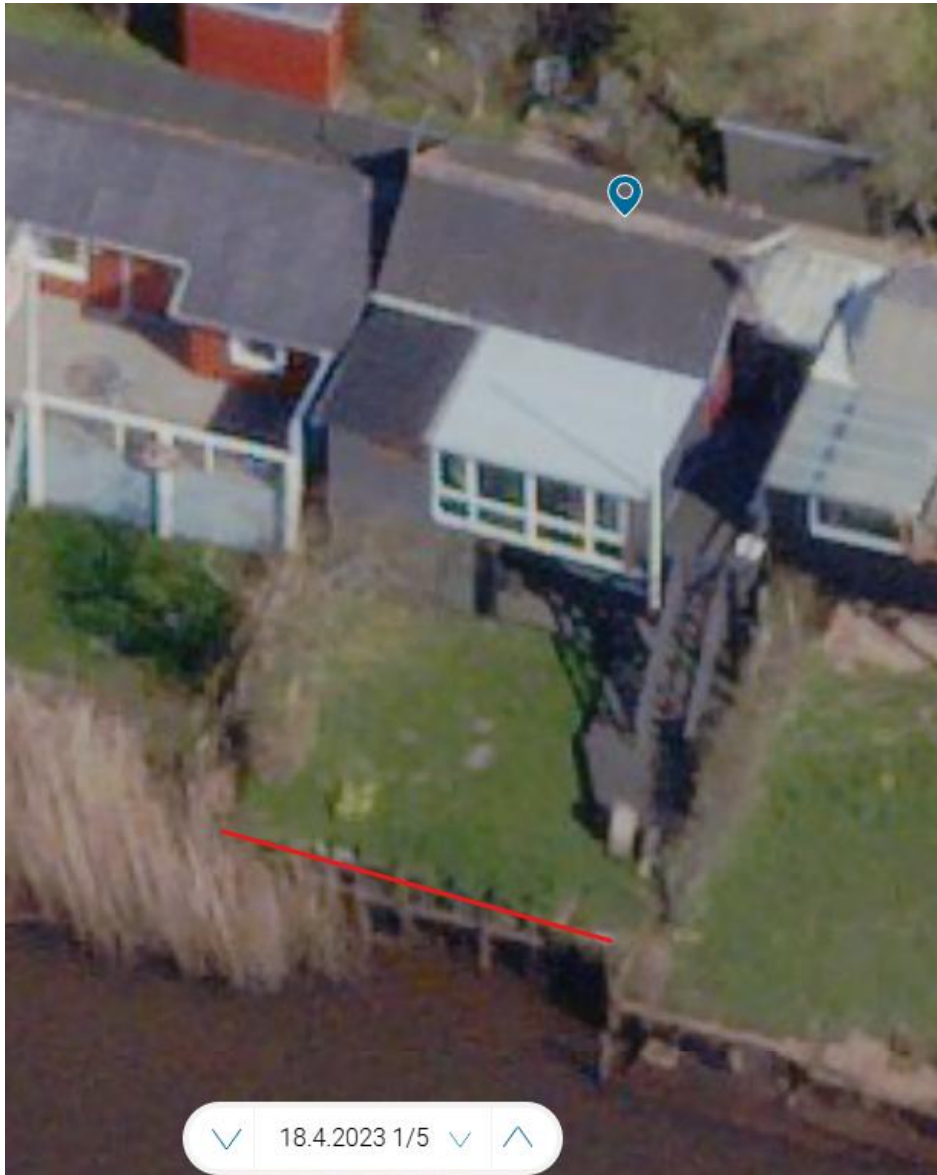
Figur 4: Den nye brinksikring etableres på samme placering, som den gamle. Placeringen ses med rød streg.
